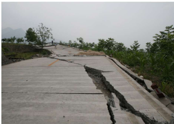
图 1.9 路基滑动路面破坏
