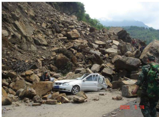
图 1.7 落石砸坏车辆、掩埋路面
