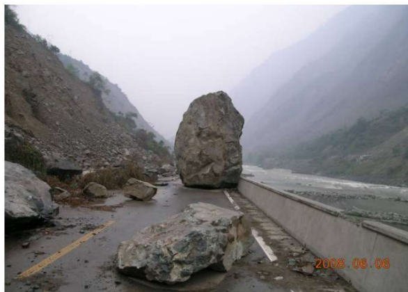
图 1.10 被巨石砸坏的路面
