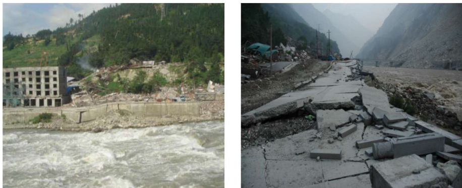
图 1.2 原水平状的路面抬高 3 m、右旋 1 m 破坏
