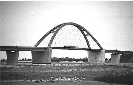
图 1-5 梁、拱组合体系桥
