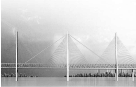
图 1-19 蒙西华中铁路洞庭湖大桥
