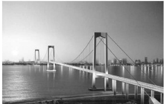
图 1-12 泰州长江大桥
