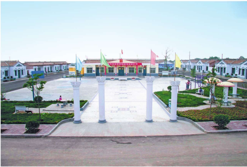
咸阳市旬邑 县排厦乡井坳村 扶贫移民新村
