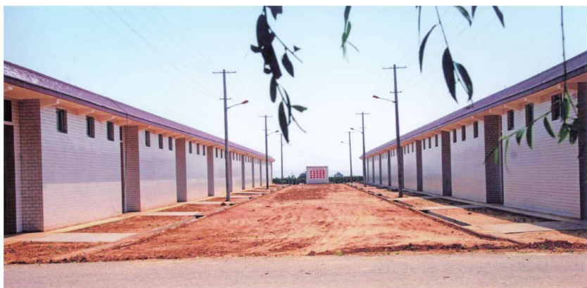
渭南市澄城 县雷家洼乡柏门 村扶贫移民新村
