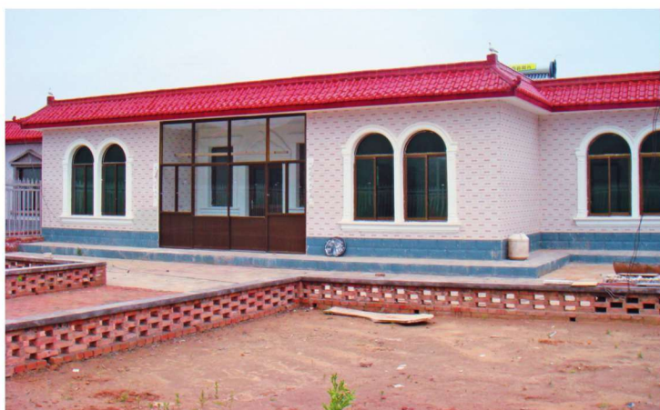
榆林市靖边 县席麻湾乡高渠 村扶贫移民新居
