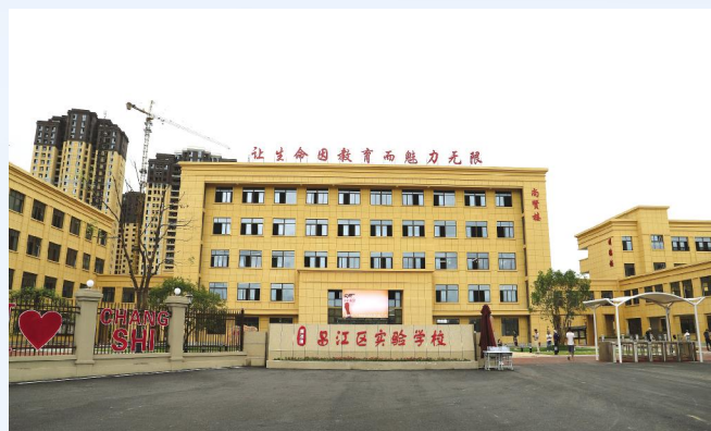
昌江区实验学校建成并投入使用
