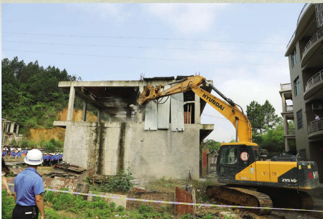
拆除违章建筑
