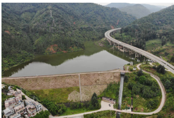
安宁龙箐水库
