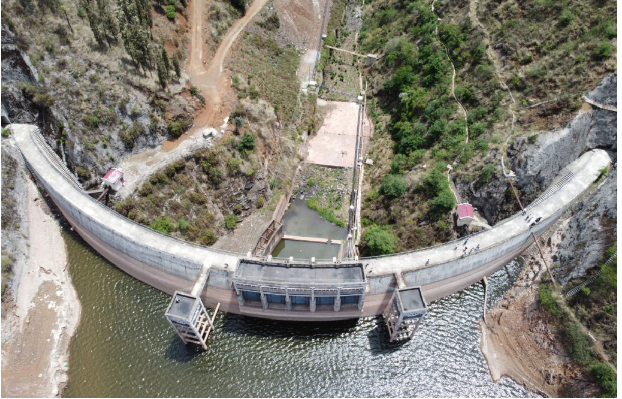
富民县兴贡水库双曲拱坝
