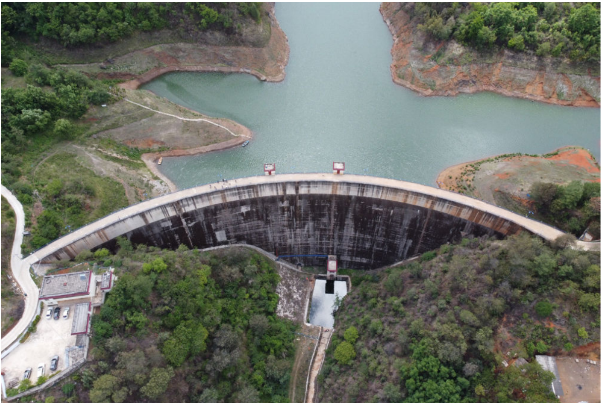
昆明市红坡水库 RCC 拱坝
