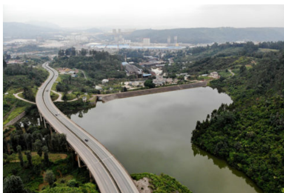
安宁龙箐水库
