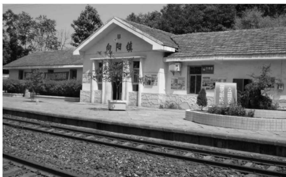
图 1.10 普通铁路车站
