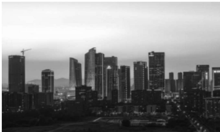
图 1-4 南京河西中央商务区实景
