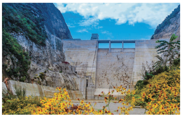
成县磨坝峡水源(水库)建设工程
