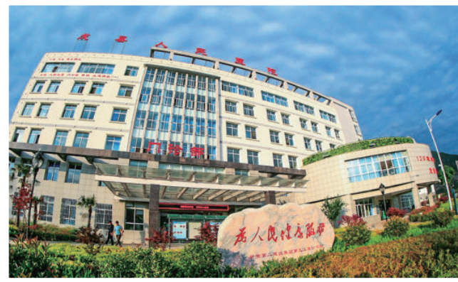
新建的成县人民医院
