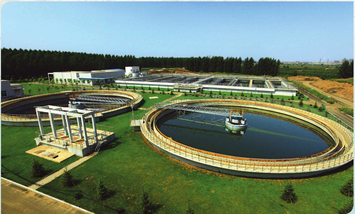
城市污水处理厂实景图
