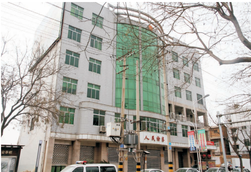
2001年建成的耀县人民检察院综合办公楼
