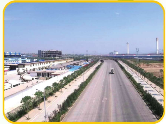
董家河产业园道路综合工程
