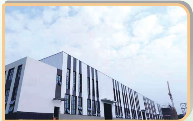
民营经济扶贫产业园标准化厂房（2号楼）
