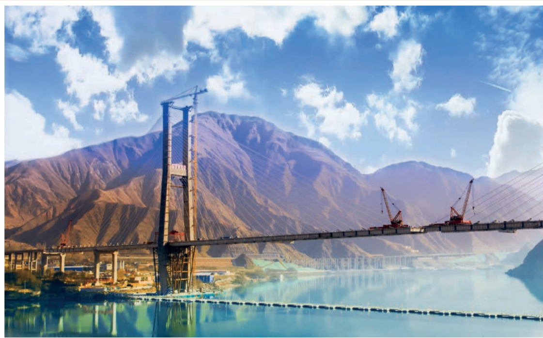
建设中的海黄大桥
