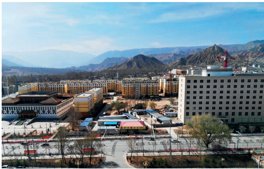
建设中的滨河小区
