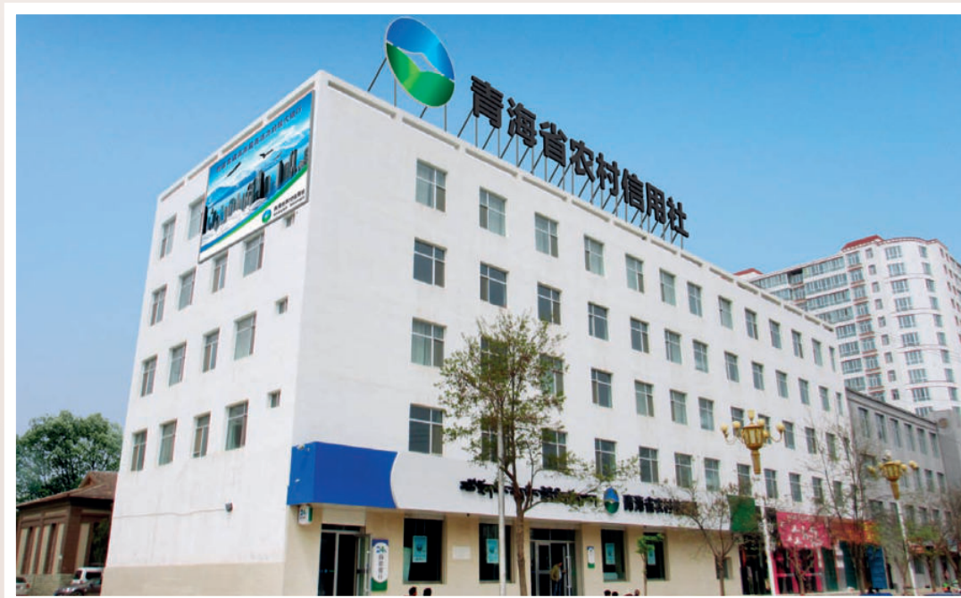
尖扎县农村信用合作联社新营业办公大楼
