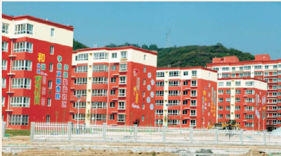
北城移民搬迁集中安置点二期工程
