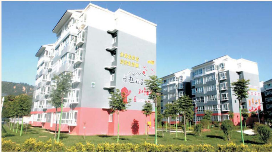
北城移民搬迁集中安置点一期工程
