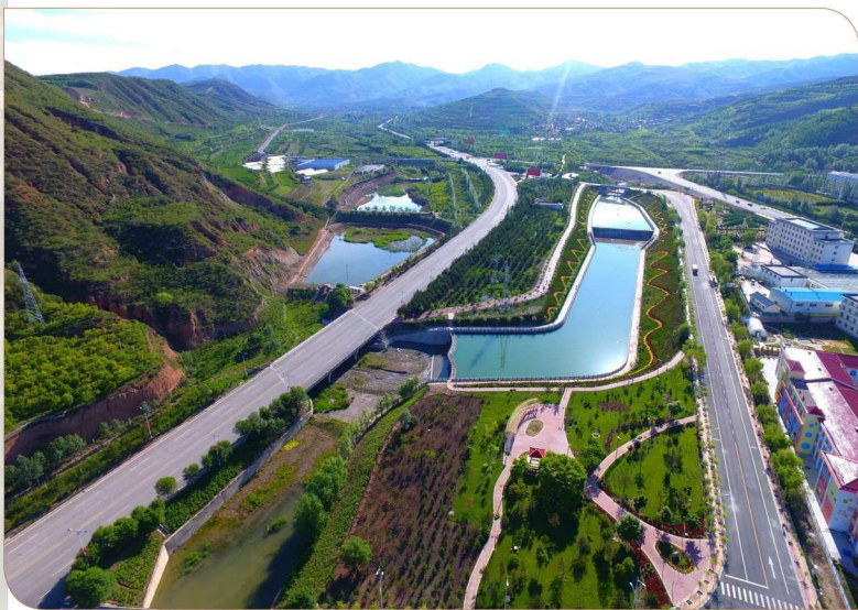
隆德渝河生态治理
