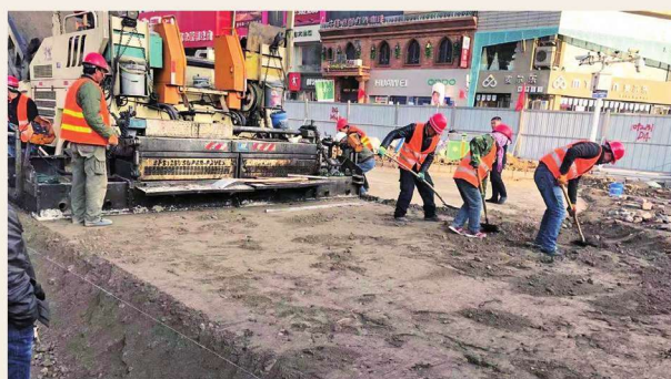
东大街基础设施改造工程
