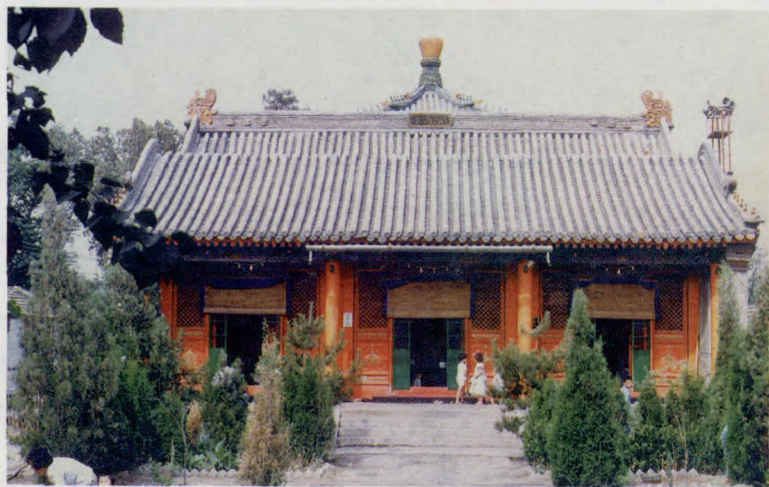
北京市昌平区西贯市清真寺大殿
