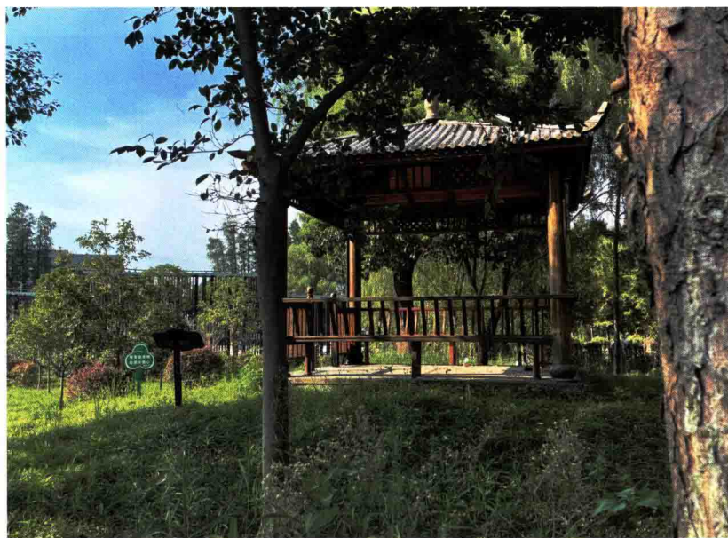
2016年竣工的三治亭
