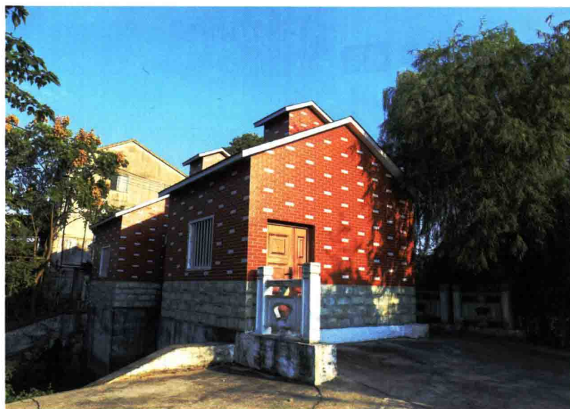
2016年改造后的吕家木桥泵站
