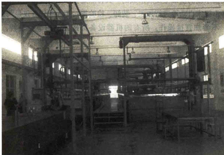
图 1-2 直线式电镀自动化生产线
