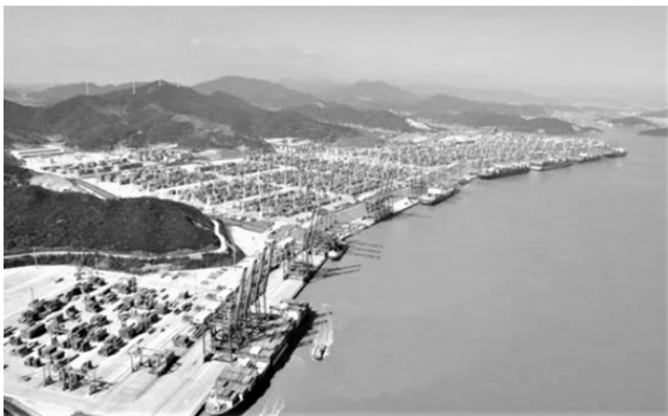
图 1-2 某港口扩建的沿海码头
