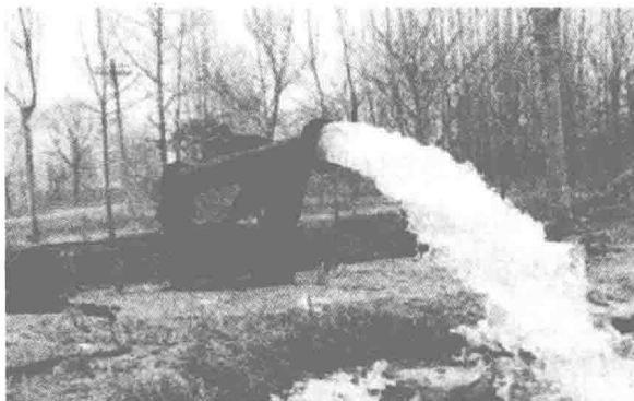
图 1-1-13 水泵电动机工作现场图
