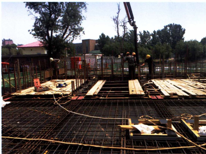
5月13日，复兴河口泵站泵房混凝土浇筑（建管中心供稿）
