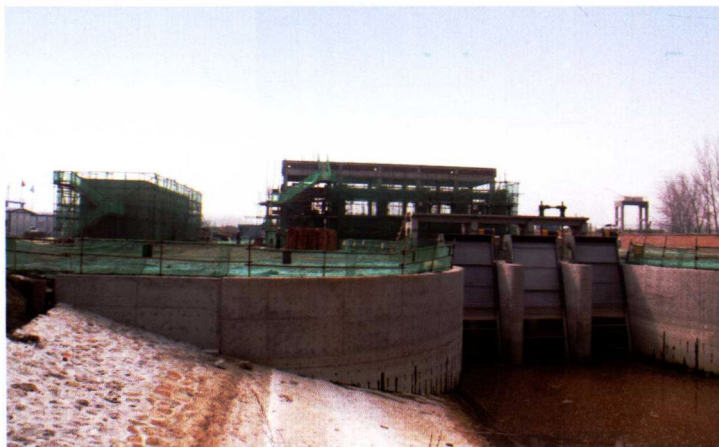
3月27日，南河泵站改造工程 (蓟州区水务局供稿)
