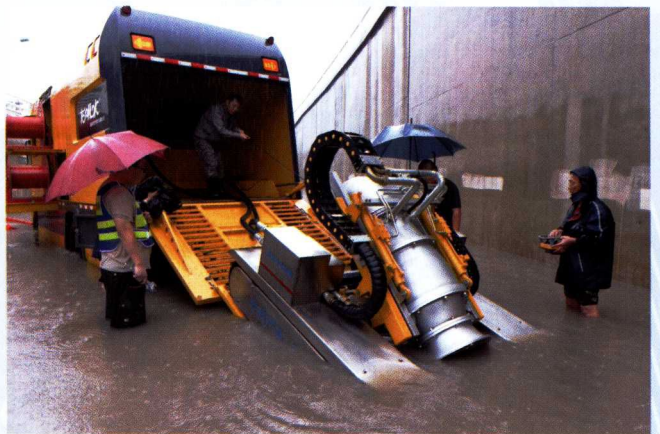
7月20日“安比”强降雨期间排水部门出动移动泵车排水作业（排管处供稿）
