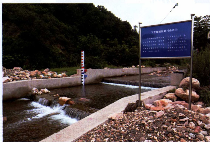
8月27日，蓟州区山洪沟治理 (局办公室供稿)
