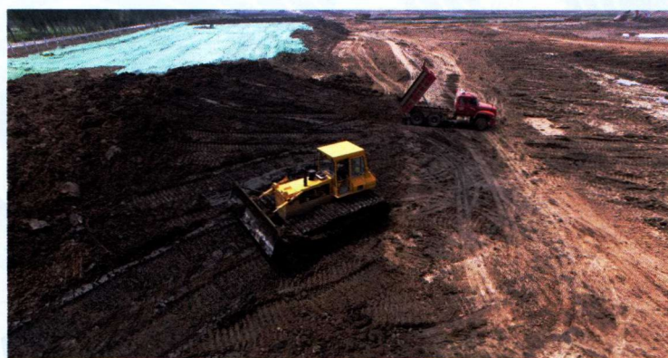
7月3日，引滦水源保护于桥水库综合治理污染底泥清除工程施工现场（建管中心 刘华夏摄）
