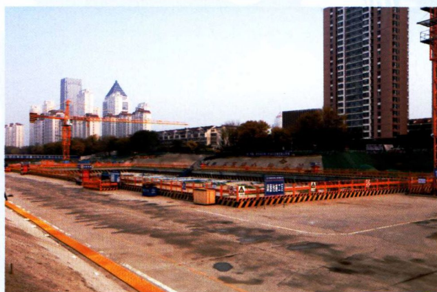
11月2日，新开河地下调蓄池建设现场（局办公室供稿）
