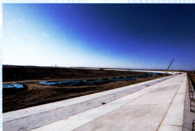
11月16日，南水北调王庆坨水库具备蓄水条件（局办公室供稿）
