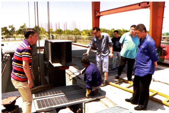
5月31日，海河口泵站施工人员对3号防潮闸进行检修（海河处 宁阳摄）
