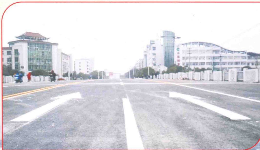
经过7个多月的施工，2018年2月1日，新干县湄湘河桥正式通车。
