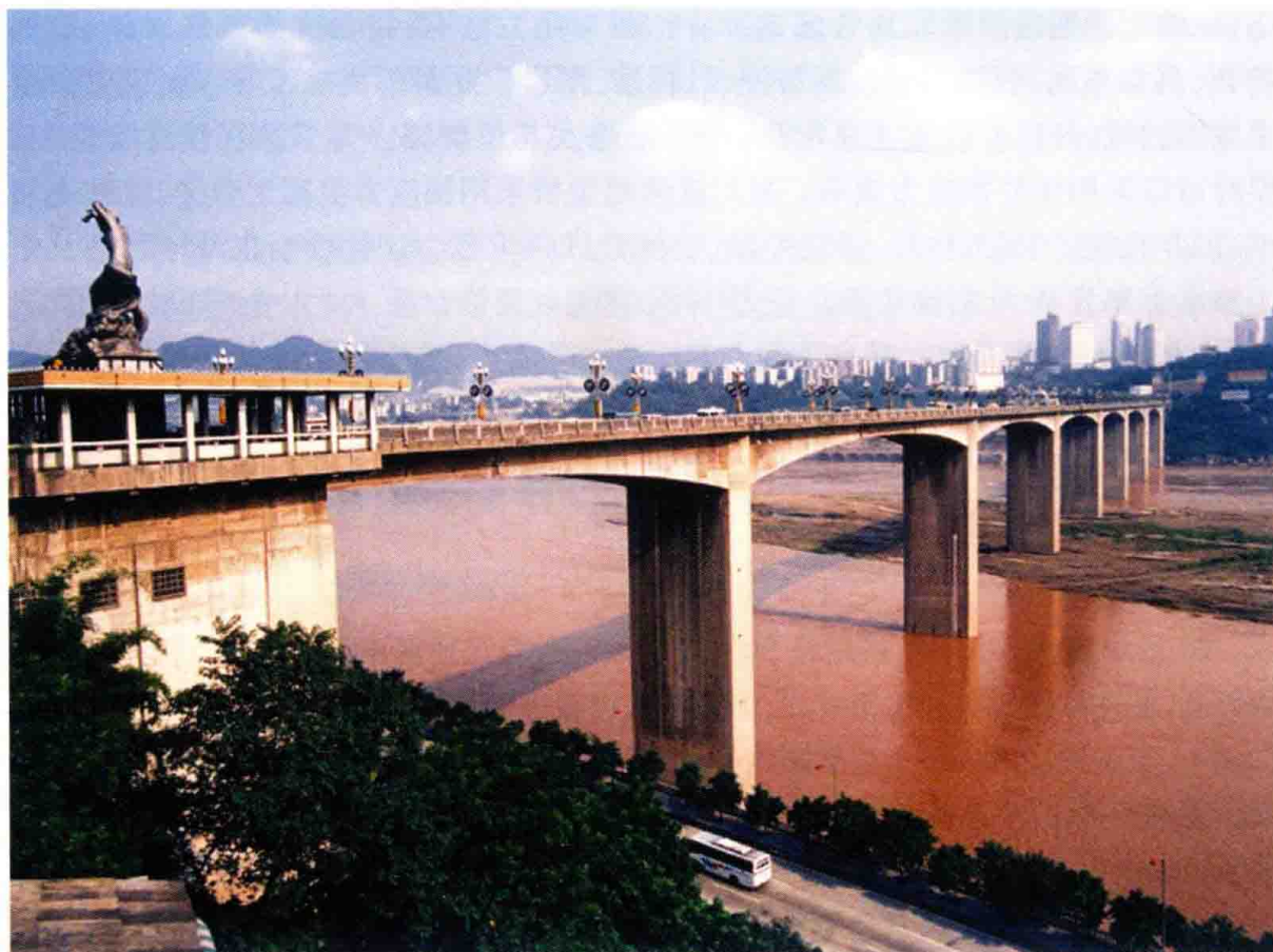
图 1.1 石板坡长江大桥
