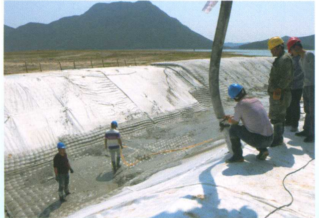
土建 4 标东张出水渠道模袋混凝土浇筑
