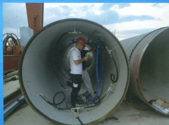
土建 3 标城门 5 号井顶管应力检测设备安装
