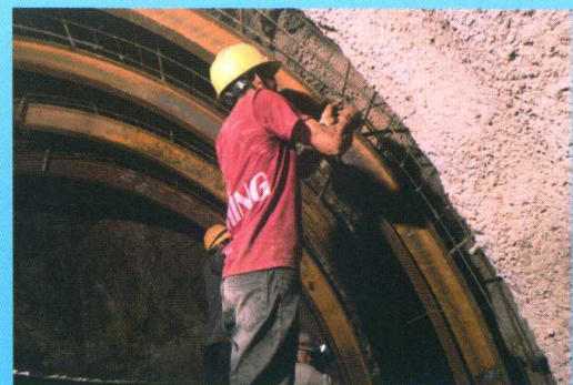
土建 4 标工人正在进行初期支护
