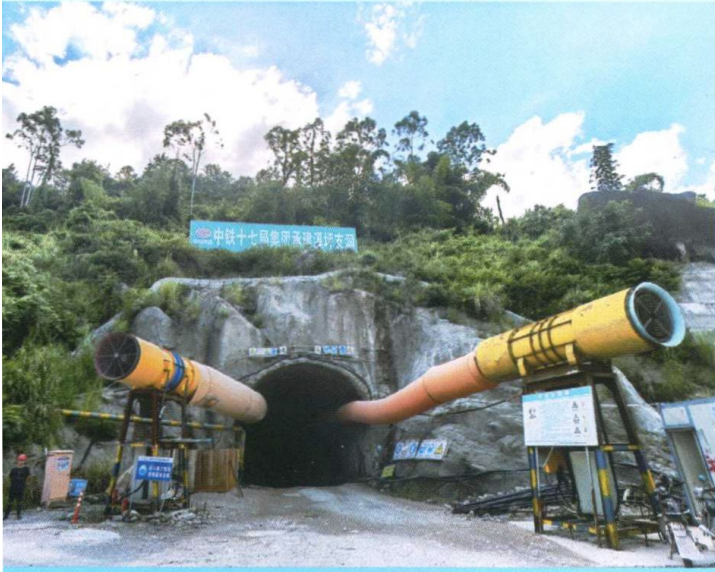
土建 1 标溪坪支洞
