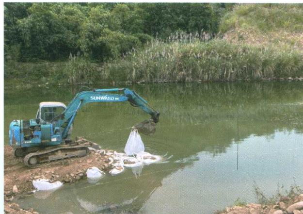
土建 1 标砂袋围堰填筑
