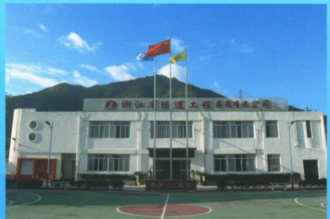
土建 4 标项目部
