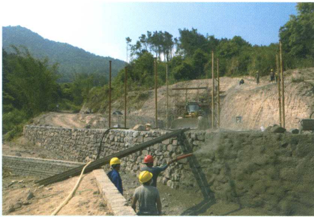
土建 4 标喷射混凝土施工
