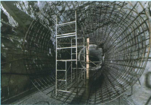
土建 4 标洞内钢筋绑扎
