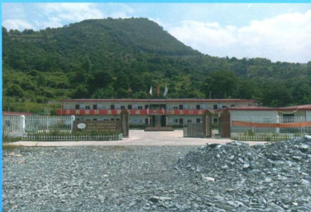
土建 1 标项目部
