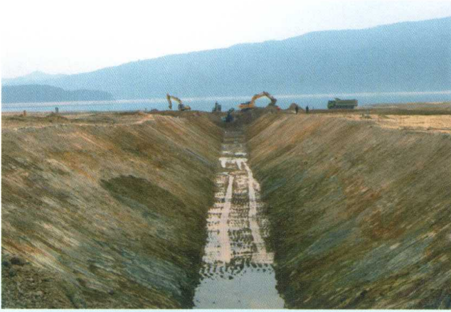
土建 4 标出水渠道土方开挖
