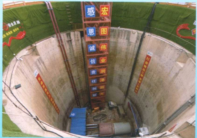
土建3标城门5号井顶管顶进
