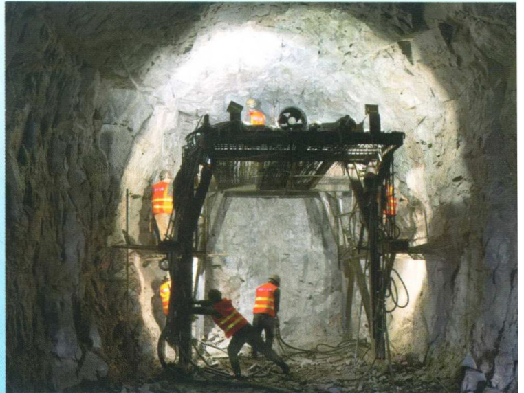
土建 1 标溪坪支洞内一片忙碌
