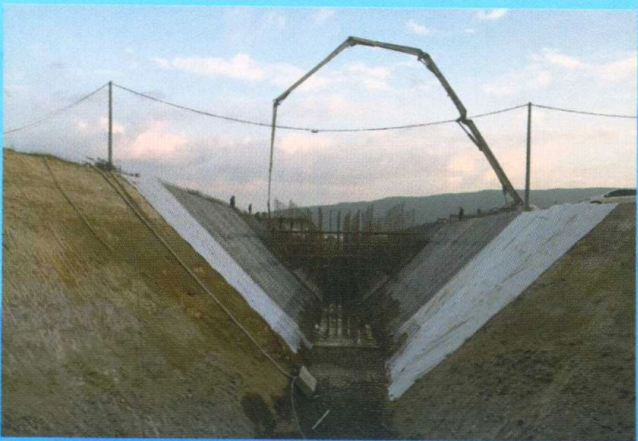
土建4标出水渠道钢筋混凝土护坡浇筑
