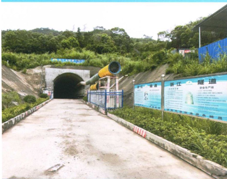
土建 4 标岭脚支洞
