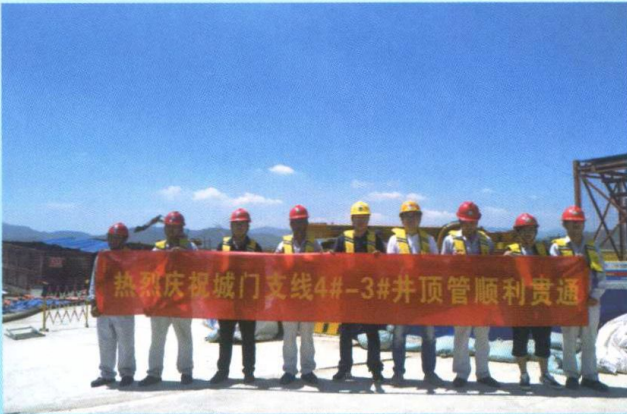
2020年6月15日，土建3标城门支线4号—3号井顶管顺利贯通
