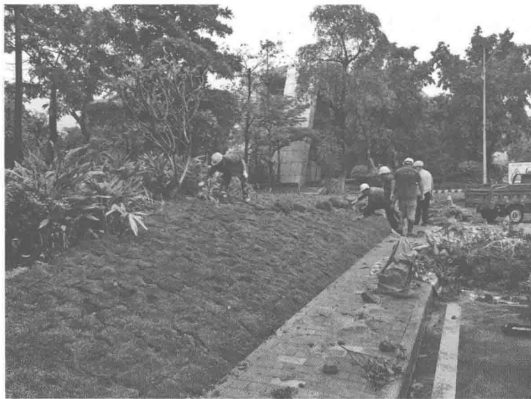
图 1-11 某项目现场照片
