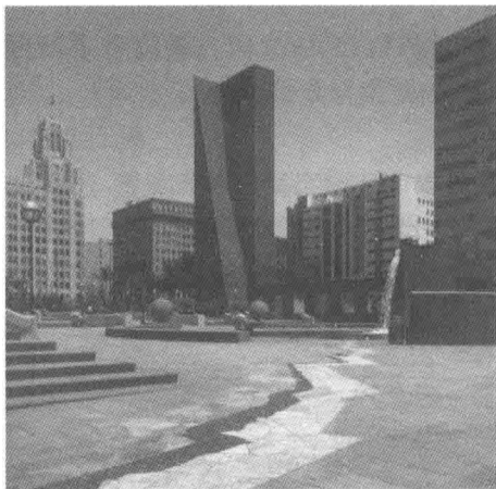
图 1-13 珀欣广场钟塔
