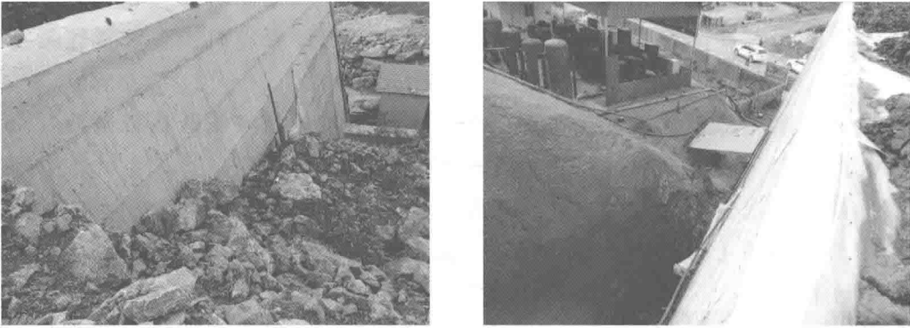
图 1.4 明洞回填大量块石
