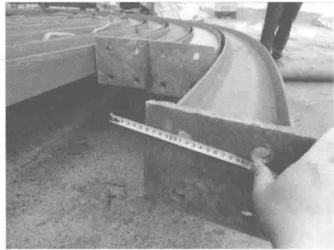
(c) 采用 M18 代替设计的 M24 螺栓，连接钢板钻孔采用 \phi 25 代替设计的 \phi 29
