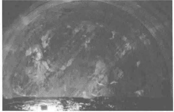
(b) IV级围岩人工开挖爆破效果照片
