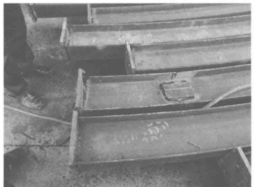
(a) 钢架连接处无加肋角钢
