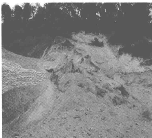
图 1.1 洞口边坡垮塌
