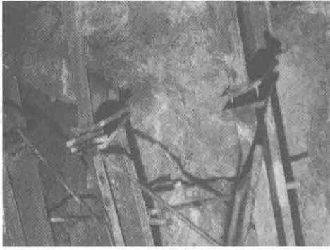
(b) 钢架法兰盘螺丝不全、连接存在缝隙，钢架法兰盘连接采用焊接
