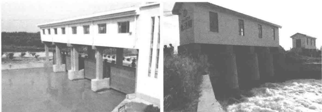
(a) 利用水工建筑物法量水
