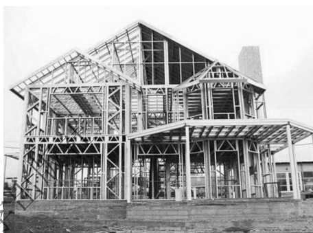
(b) 装配式钢结构建筑
