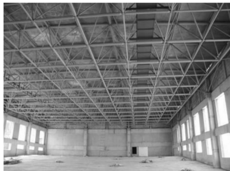
(d) 骨架板材建筑
