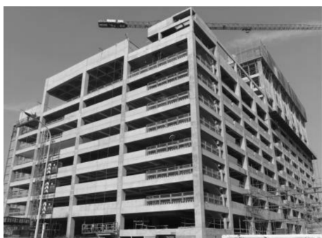
(a) 装配式混凝土建筑
