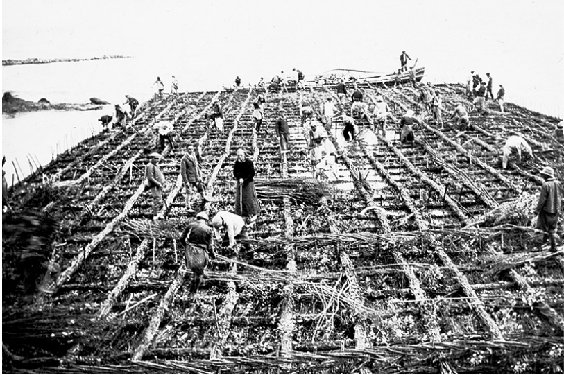
南通沿江筑榵工程工地
