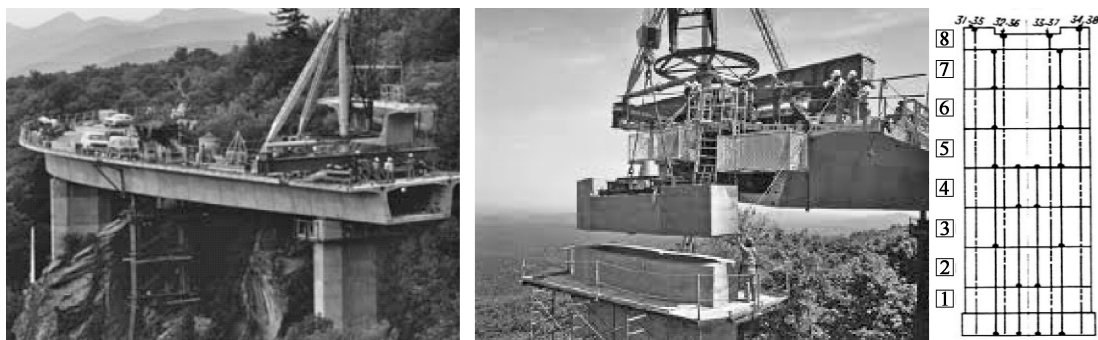
图 1.1 Linn Cove 高架桥(预应力筋连接构造)
