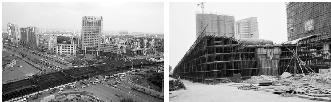
图2 桥梁传统建造模式对城市既有交通影响非常大
