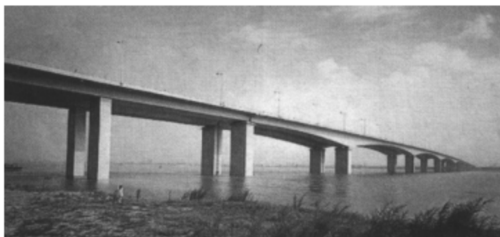
图 1-4 南京长江第二大桥北汊桥
