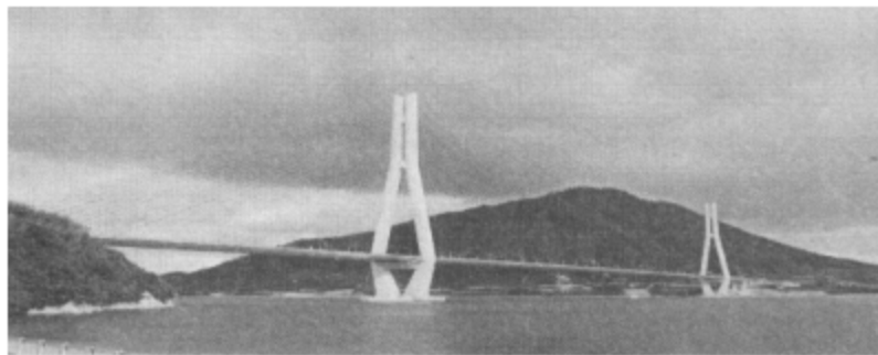
图 1-19 日本多多罗桥
