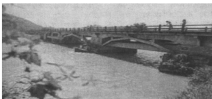
图 1-2 福建漳州虎渡桥
