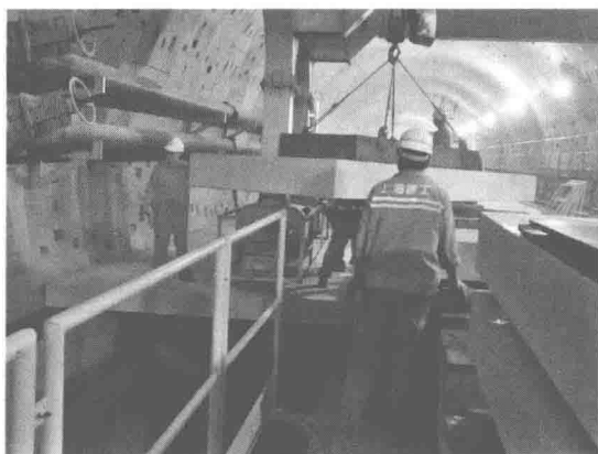
图 1.4 江浦路越江隧道车道板安装
