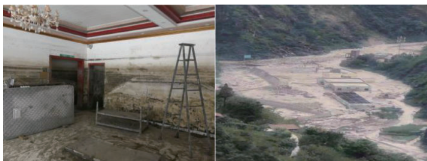
图 20 四川汶川县“2019·8·20”特大山洪泥石流灾害
