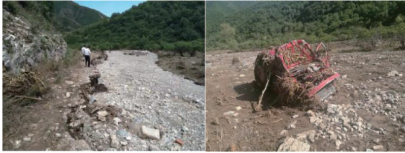
图 14 北京门头沟区“2017·6·18”山洪灾害
