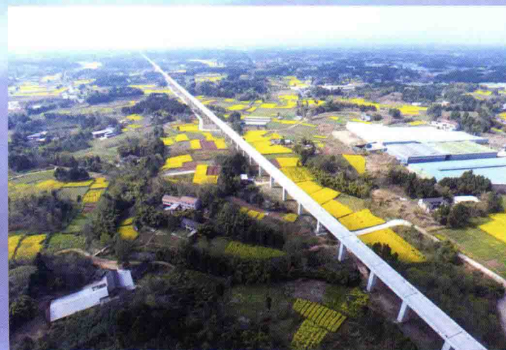
四川省成都市轨道交通 8 号线太平隧道三岔站高架区间工程，由水电六局承建
