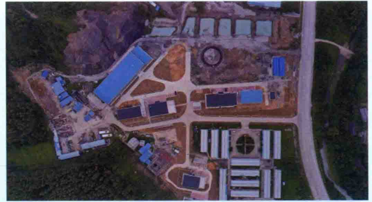
广东省江门市中微子实验站配套基建工程，由水电六局承建
