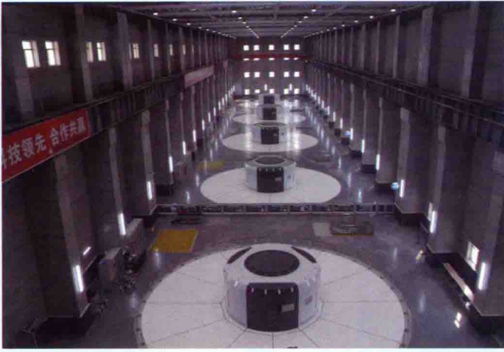
吉林省吉林市境内的丰满水电站全面治理（重建）工程，由水电六局承担水电站发电厂房及机电安装工程
