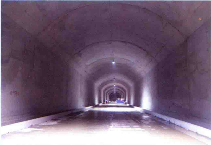
乌东德水电站进厂交通洞工程，由水电六局承建
