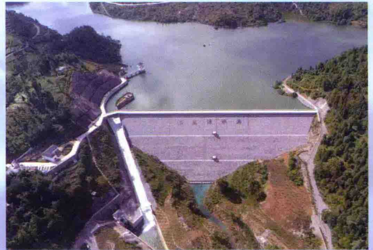
贵州省兴义市小龙潭水利枢纽工程，由水电六局承建
