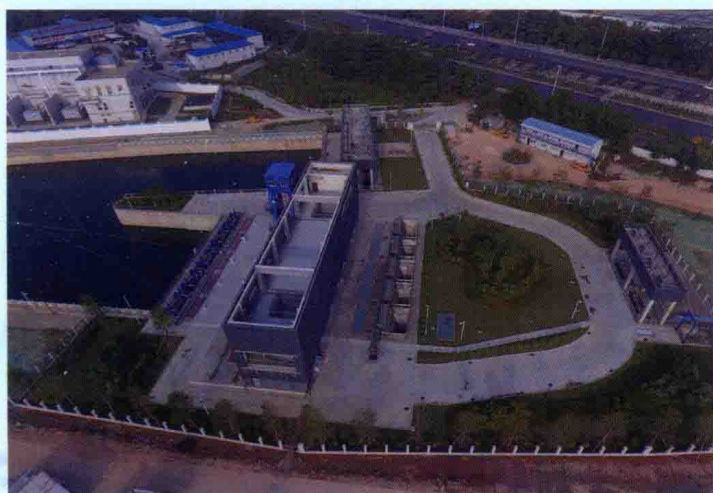
广东省深圳市茅洲河流域（宝安片区）水环境综合整治九标段项目，由水电六局承建，该工程获 2018 年深圳市优质结构工程奖
