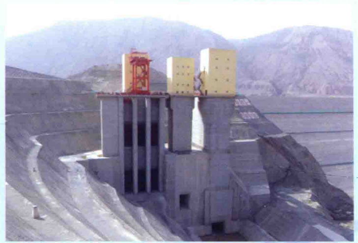
新疆维吾尔自治区乌恰县境内的卡拉贝拉水利枢纽工程，由水电六局承担左岸泄水建筑物工程施工
