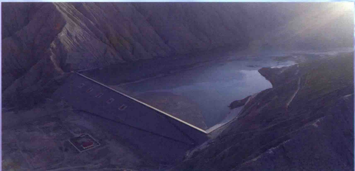
新疆维吾尔自治区皮山县阿克肖水库工程，由水电六局承建
