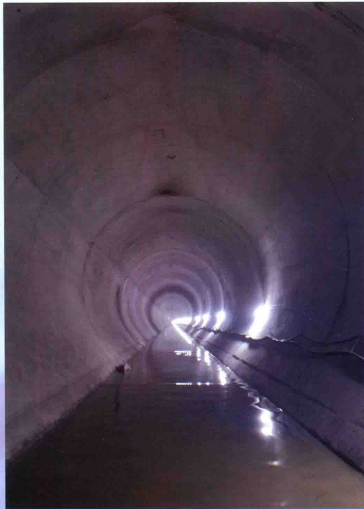
浙江省杭州市第二水源千岛湖配水 4 标工程，由水电六局承建
