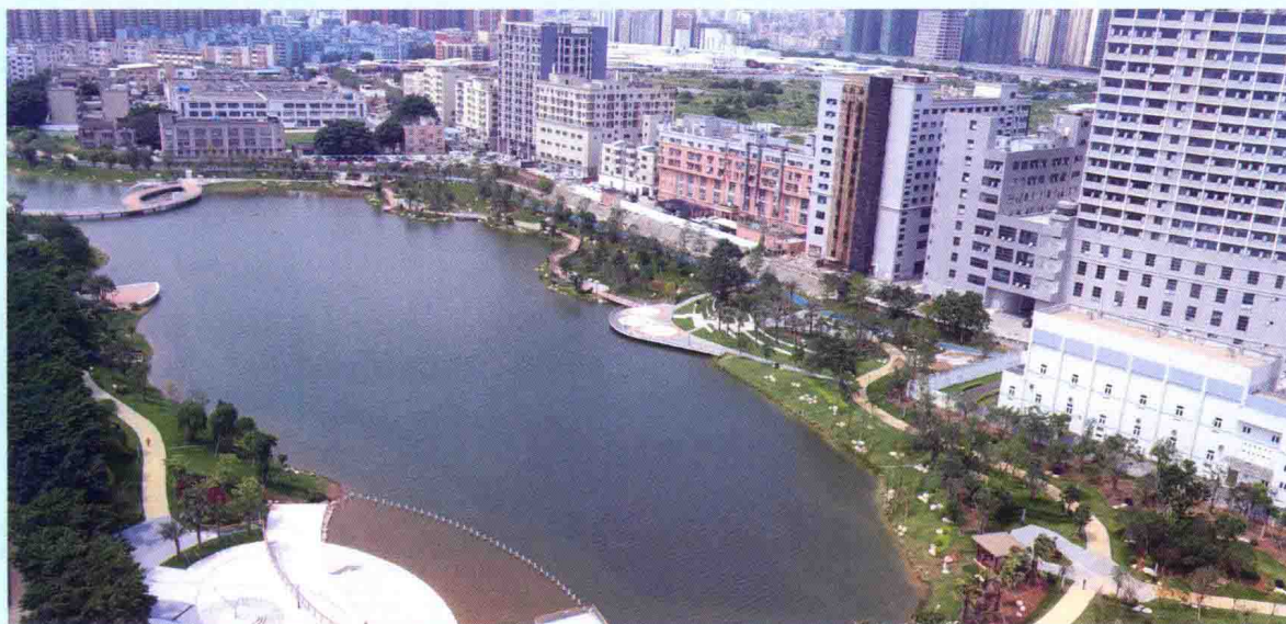
广东省深圳市茅洲河流域（宝安片区）水环境综合整治万丰湖湿地公园项目，由水电六局承建，该工程获深圳市 2019 年度绿色施工示范工程奖
