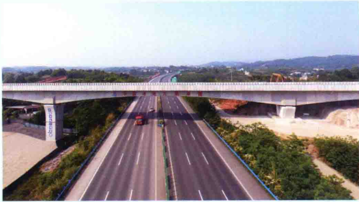
四川省成都市轨道交通 8 号线第二绕城高速公路连续梁桥工程，由水电六局承建
