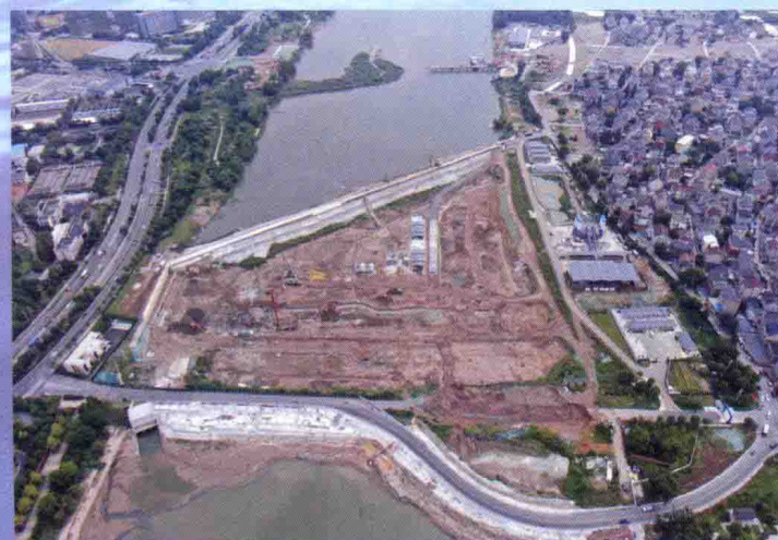
浙江省杭州市富阳区亚运会场馆及北支江综合整治 EPC 项目，由水电六局承建
