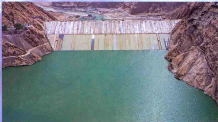
新疆维吾尔自治区叶尔羌河流域的阿尔塔什水利枢纽大坝面板表面防护封闭工程，由水电六局承建
