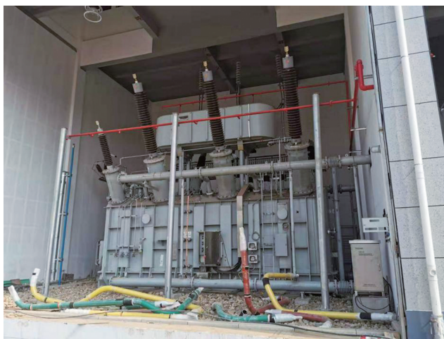
图 1-6 主变室采用可打开的大门设计
