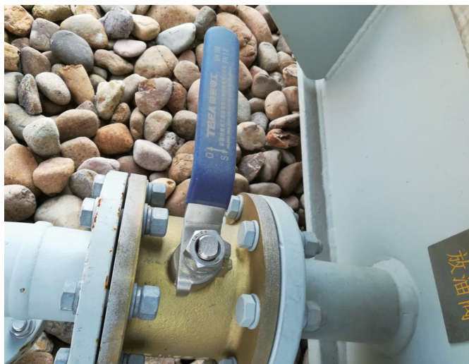
图 1-4 阀门必须根据实际需要处在关闭和开启位置且开闭标志清晰
