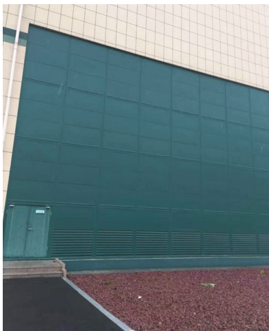
图 1-5 主变室采用小门设计
