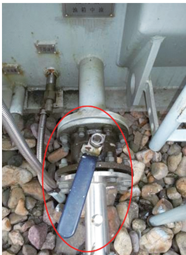
图 1-3 阀门指示不清晰，阀门无明确指示开闭位置的标志
