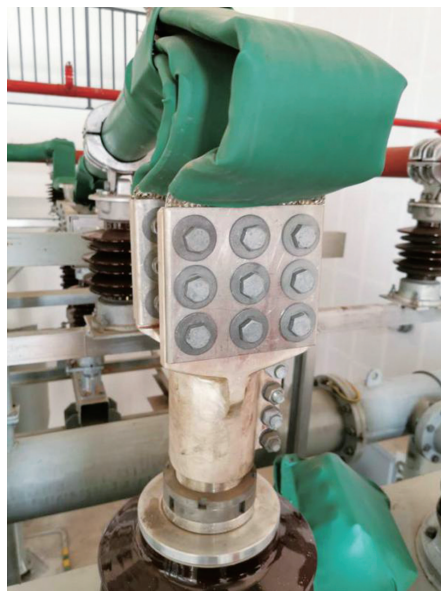
图 1-2 套管软连接
