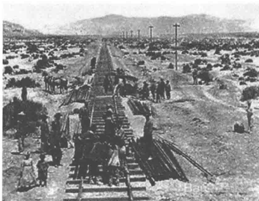
图 1-6 美国 20 世纪拆除铁路的场面
