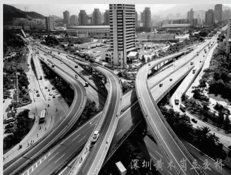
图 1.1 深圳市黄木岗立交桥
