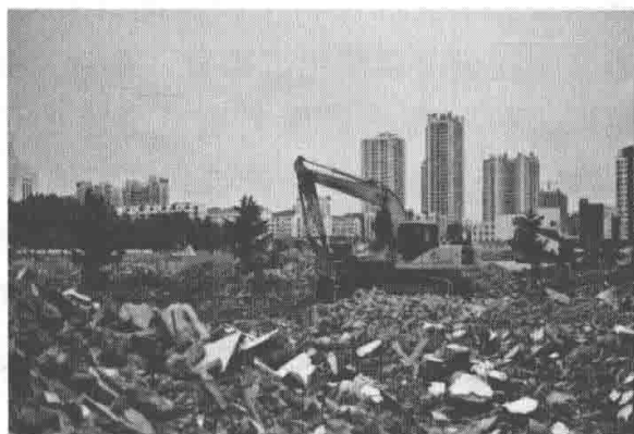
图 1.3 建筑垃圾围城
