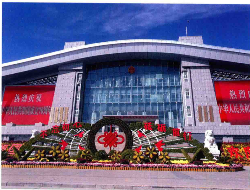
2019年国庆节期间的合作中心联检大楼
