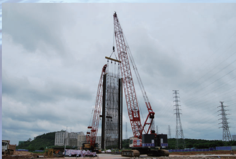
广东省珠江三角洲水资源配置工程土建施工C1标工程，由水电十四局承建
