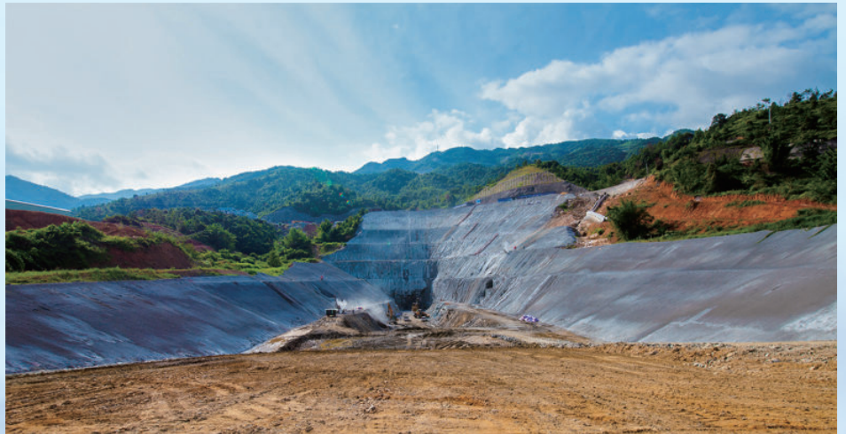
广东省梅州市五华县抽水蓄 能电站输水发电系统土建工程 C3 标下库进出水口开挖支护工程， 由水电十四局承建
