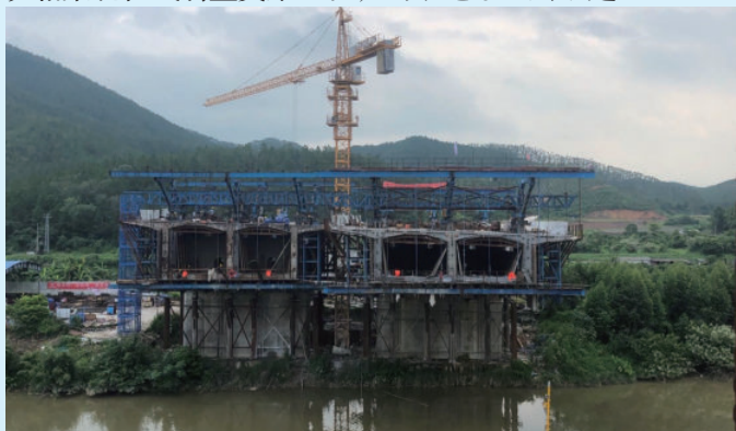
广东省江门市台山至开平快速路及龙山支线下洞大桥 2# 块施工，该工程由水电十四局承建
