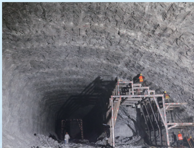
福建省永泰县抽水蓄能电站主副厂房洞扩挖工程，由水电十四局承建
