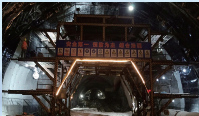
广东省佛（山）清（远）从（化）高速公路北段工程二分部石牛岭隧道铺设防水板工程，由水电十四局承建
