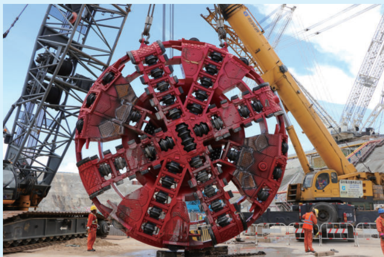
某核电厂排水隧洞工程盾构机刀盘吊装，该工程由水电十四局承建
