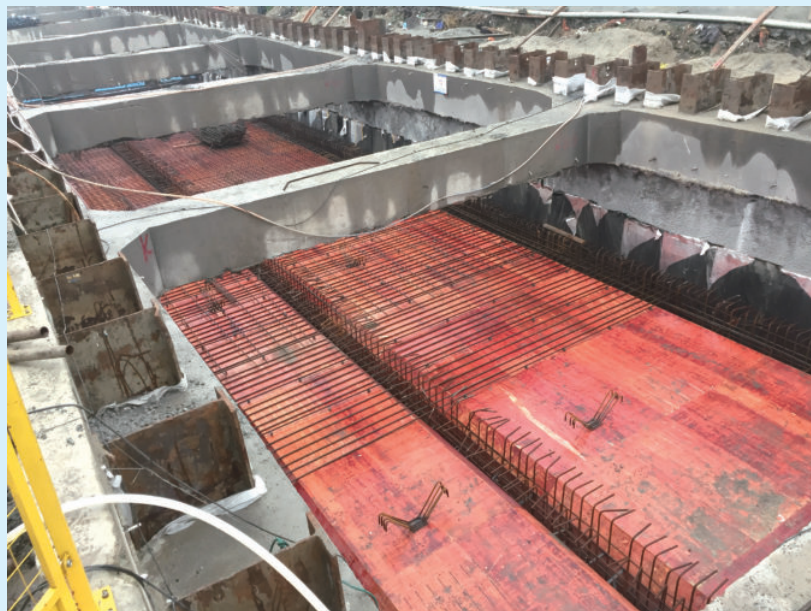
浙江省杭州市大江东大道提升改造及管廊工程第三标段，该工程由水电十四局承建
