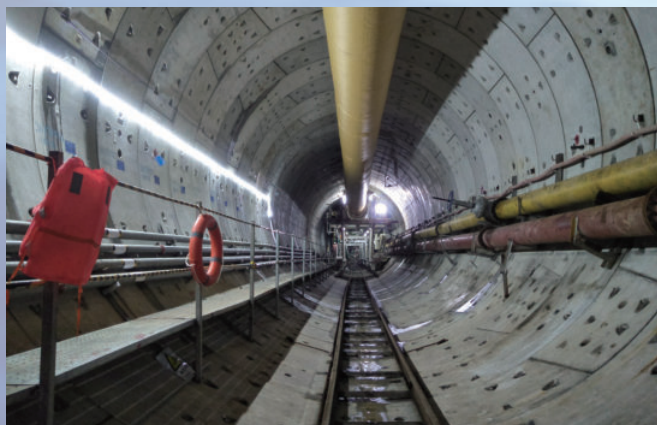
某核电厂排水隧洞工程 1# 排水隧洞盾构法隧道，该工程由水电十四局承建
