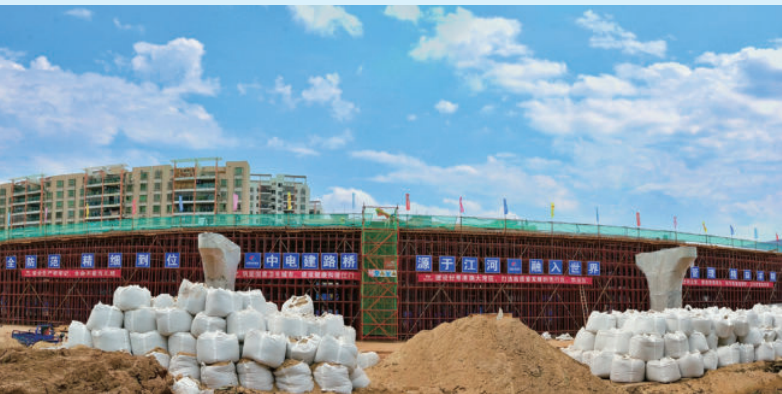
广东省江门市五邑路扩建工程金星路跨线桥第四联现浇箱梁碗扣式满堂支架工程，由水电十四局承建
