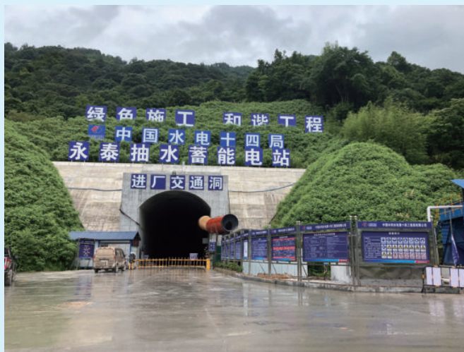
福建省永泰县抽水蓄能电站 C2 标进厂交通洞标准化布置工程，由水电十四局承建
