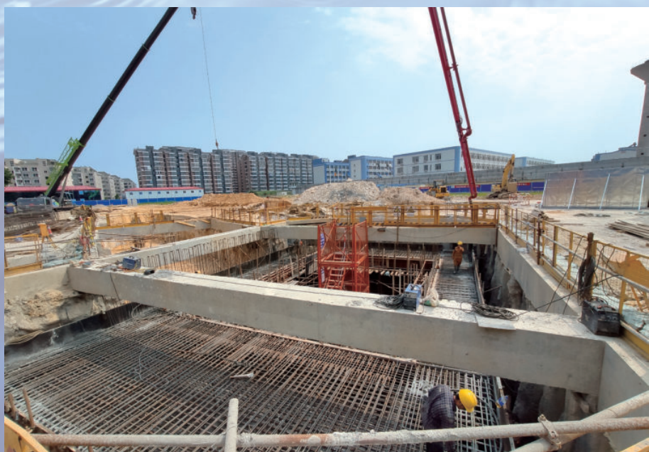
福建省沙县南平至龙岩铁路扩能改造工程第二标段官庄特大桥工程，由水电十四局承建
