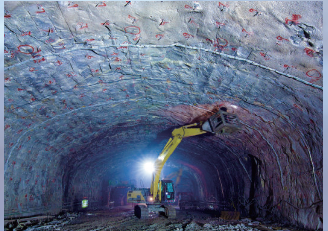
广东省梅州市五华县抽水蓄能电站输水发电系统土 建工程 C3 标主变洞 I 层支护工程，由水电十四局承建
