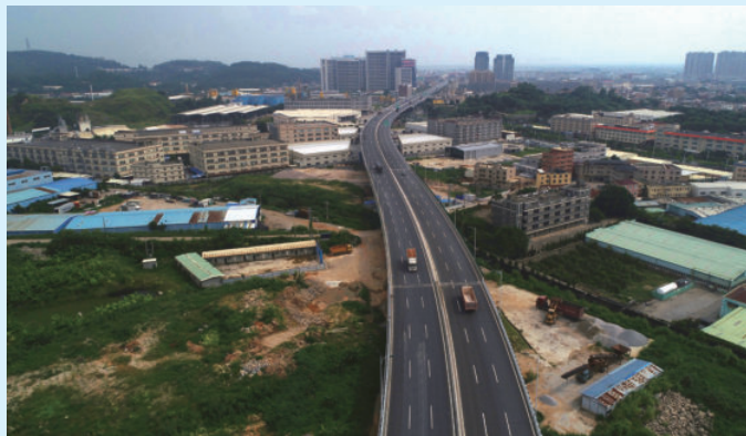
福建省国道 319 线漳州市段改线一期工程（厦漳同城大道）锦宅村特大桥，该工程由水电十四局承建
