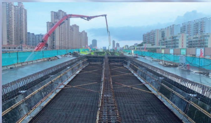
广东省江门市五邑路扩建工程金星路跨线桥右幅第二联底腹板现浇施工，该工程由水电十四局承建
