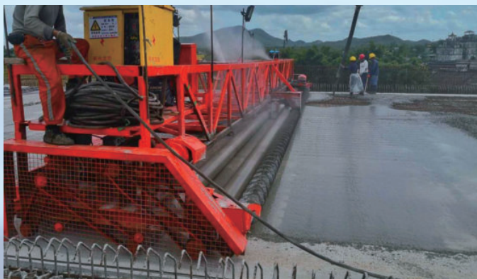
广东省江门市台山至开平快速路及龙山支线下洞大桥桥面调平层浇筑，该工程由水电十四局承建
