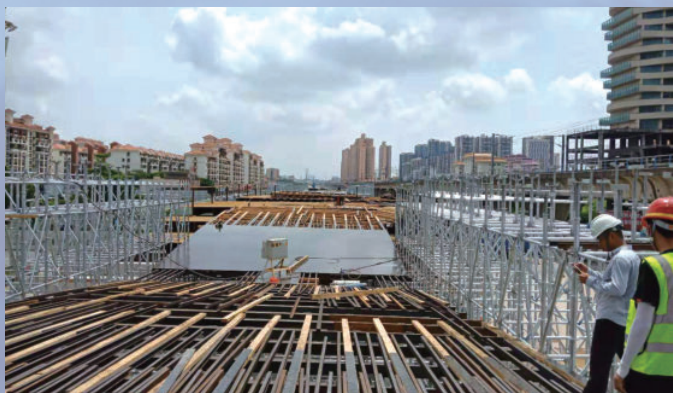
广东省江门市五邑路扩建工程东海路跨线桥左幅第三联现浇箱梁底模安装施工，该工程由水电十四局承建
