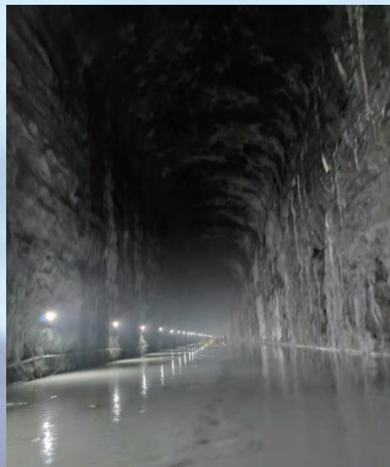
某地下水封洞库原油洞罐区地下结构工程，由水电十四局承建
