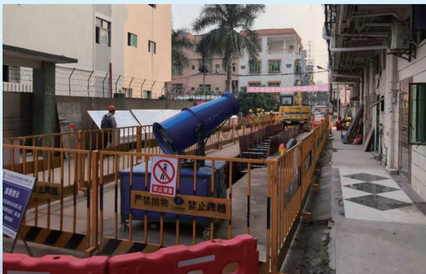
广东省东莞市石马河流域综合治理工程，由水电十四局承建
