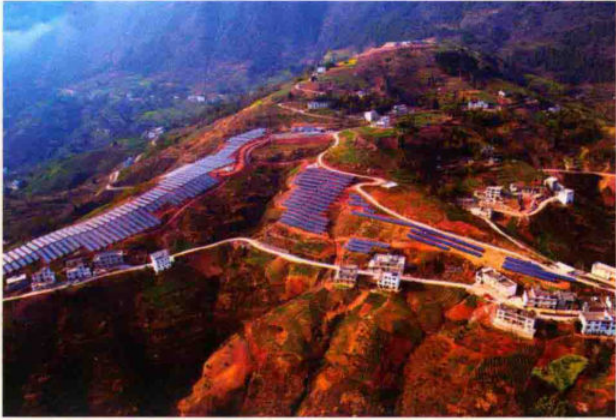
2017年3月1日，国家电网公司定点帮扶的巴东县118个村级光伏电站（涉及12个乡镇127个行政村）开工建设，6月15日建成投产 王美洲 摄
