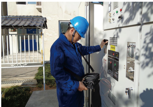
图 3 电缆局放仪检测
