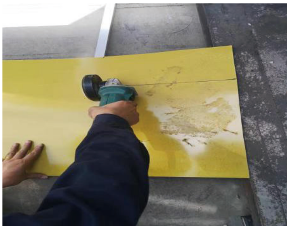
图 9 切割防火板
