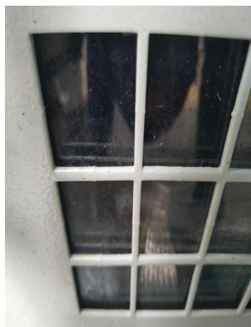
图8 电缆仓位检查
