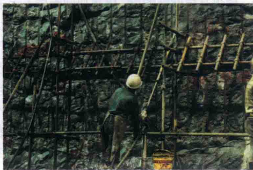
图 1-15 岩壁吊车梁斜孔钻孔样架
