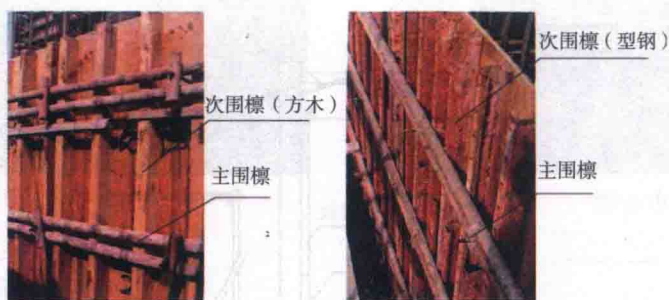
图 1-24 岩壁吊车梁围檩组成
