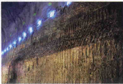
图 1-16 岩壁吊车梁光爆效果
