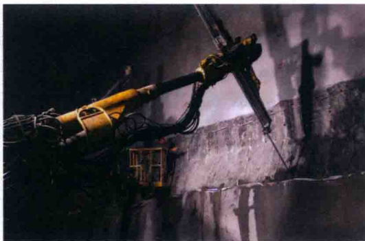
图 1-18 钻锚杆孔
