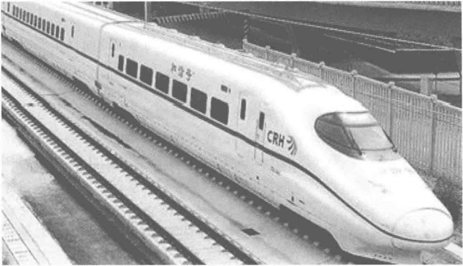
图 1.3 中国高铁铁路工程
