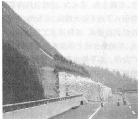
图 1.1 滑坡抢险占路压脚
