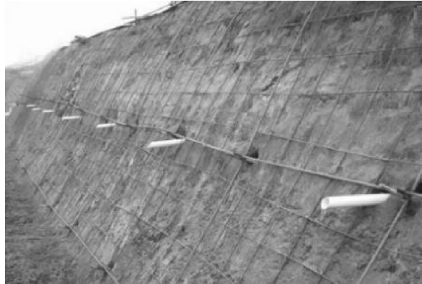
图 1-7 土钉墙支护
