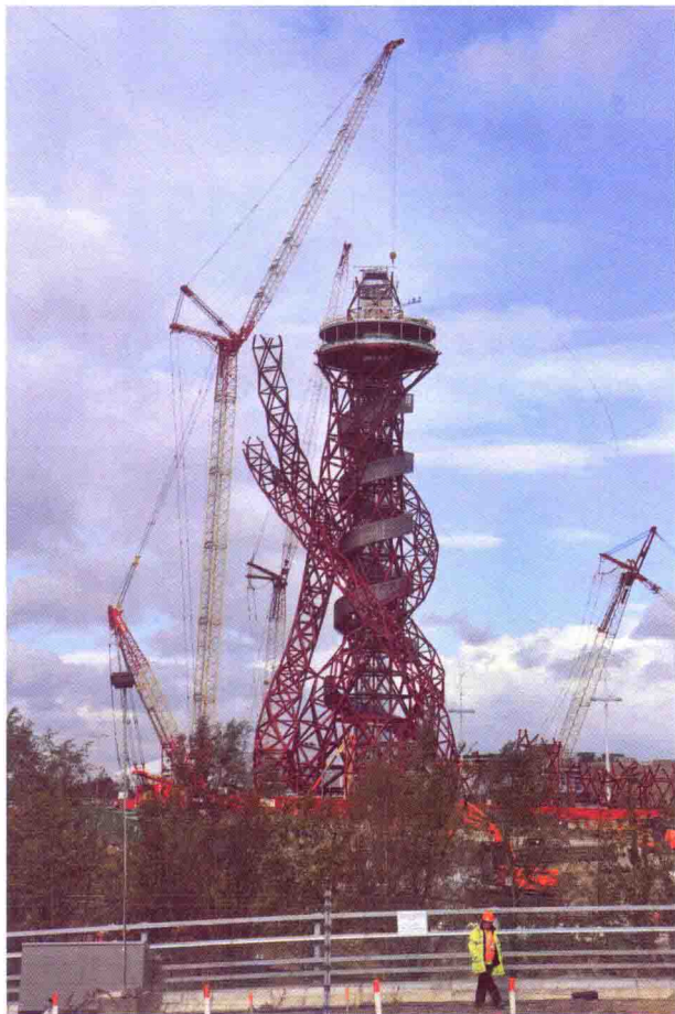
图 1-26 《轨道塔》正在施工
