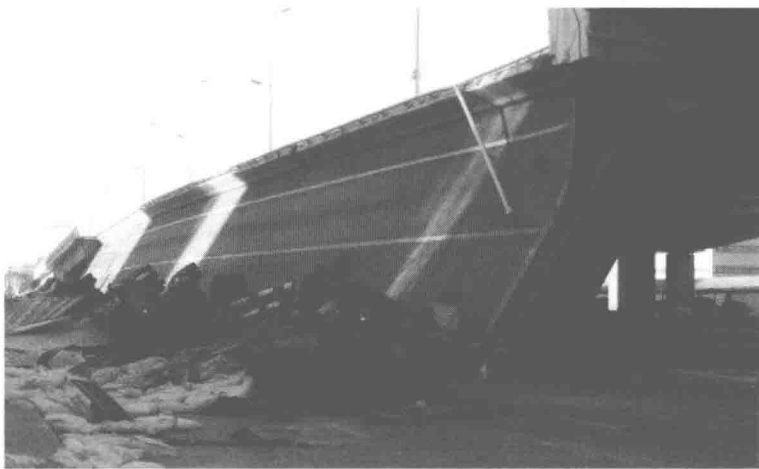
图 1-11 哈尔滨阳明滩大桥引桥发生倾覆垮塌事故现场
