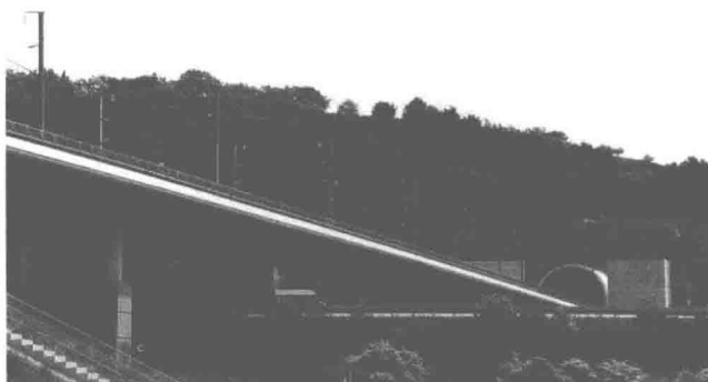
图 1-9 法国 TGV 地中海线 Bonpas 铁路桥
