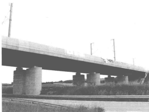
图 1-8 法国 TGV 东欧线 A31 铁路桥
