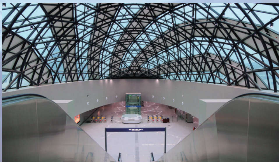
湖北省武汉市地铁 11 号线 2 标段光谷七路站采光天窗工程，由水电四局承建
