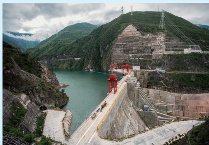
位于云南省兰坪县境内的黄登水电站工程，水电四局承担了该电站进场公路、坝肩开挖、大坝土建及金属结构安装等施工
