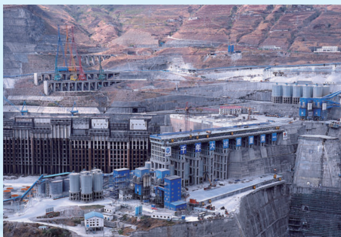
白鹤滩水电站混凝土拌和系统，由水电四局负责系统建设、安装和运营
