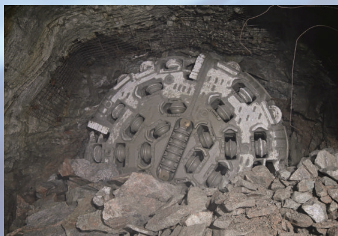
甘肃省兰州市水源工程二标段双护盾全断面硬岩隧洞掘进施工，由水电四局承建
