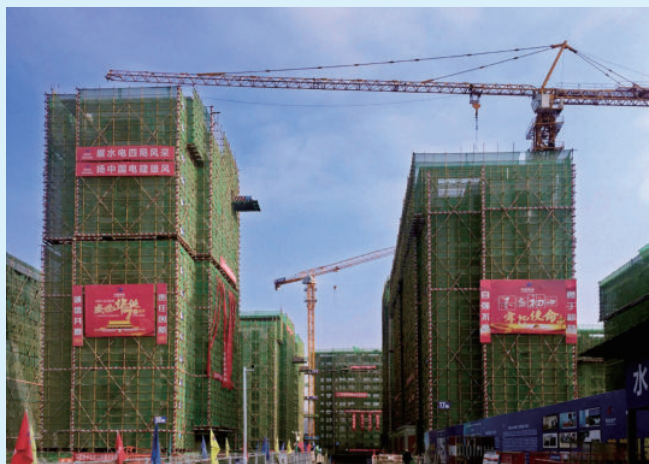
四川省成都市洛悦玺小区二期工程，由水电四局承建
