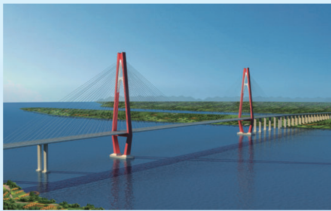
广东省中山至开平高速公路江门段银洲湖特大桥工程，由水电四局总承包
