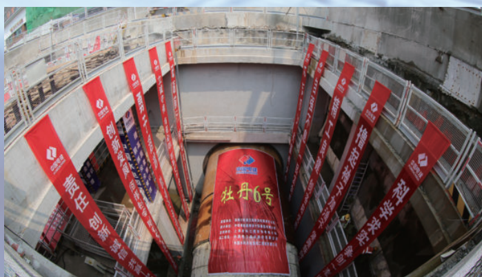
由水电四局承建的河南省洛阳市地铁 2 号线 3 站 2 区间工程，正在进行盾构机“牡丹 6 号”始发
