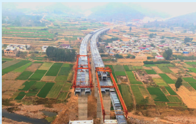
太行山高速公路河北省邢台段沙河2号大桥右幅钢混工字梁工程，由水电四局承建
