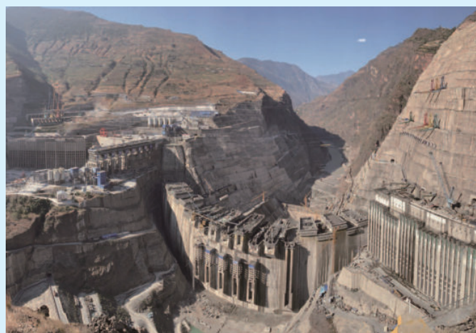
正在施工中的白鹤滩水电站，水电四局承担了左岸坝肩开挖、土建，缆机安装运行、混凝土拌和系统及金属结构制安施工
