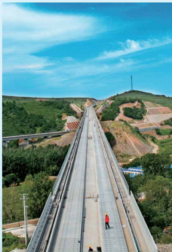
京沈铁路半截塔特大桥，由水电四局承建
