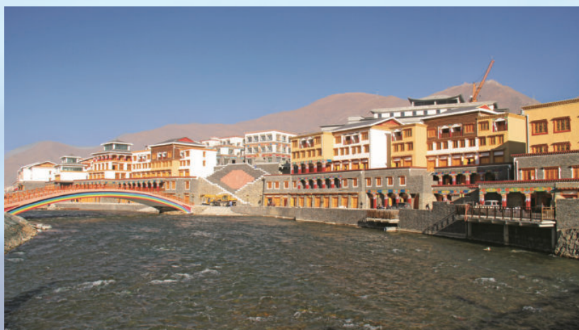
四川省广汉市金雁湖公园桥闸工程，由水电四局承建
