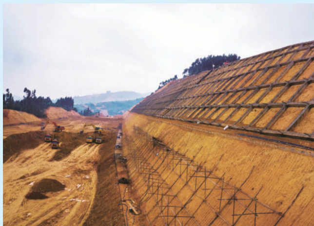
云南省昆明市晋红高速四标段工程，由水电四局承建
