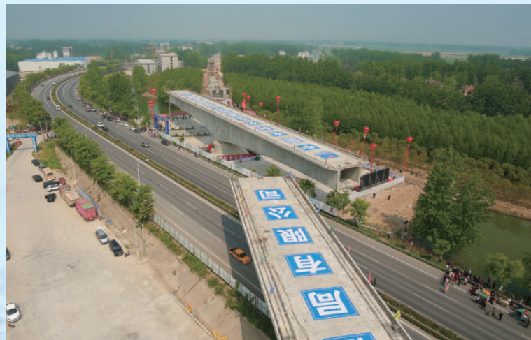
江苏省境内的徐宿淮盐城际铁路 2 标段双沟转体特大桥工程，单个 T 构长 132m、重 9951t，由水电四局承建
