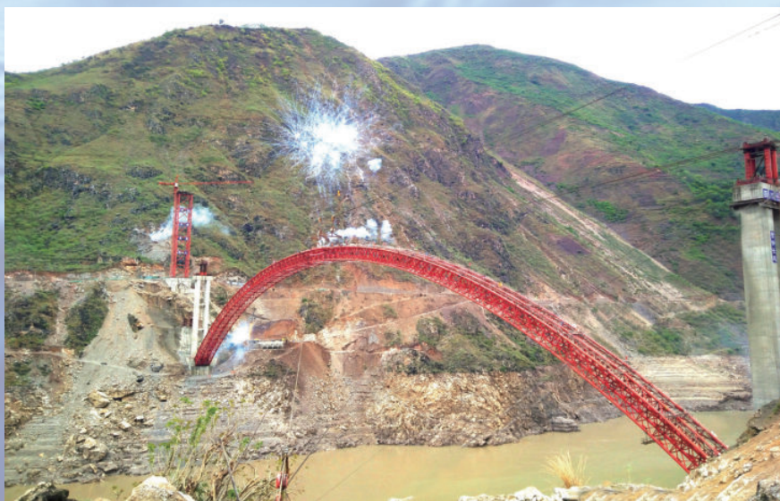
四川省凉山州大跨径“溜索改桥”工程，由水电四局承建
